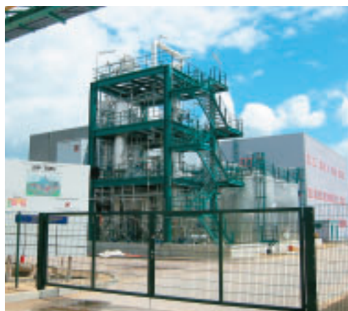
(特殊ビスフェノールプラント全景)
