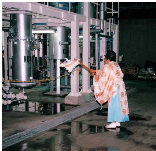
(現像液再生プラントの竣工式)
